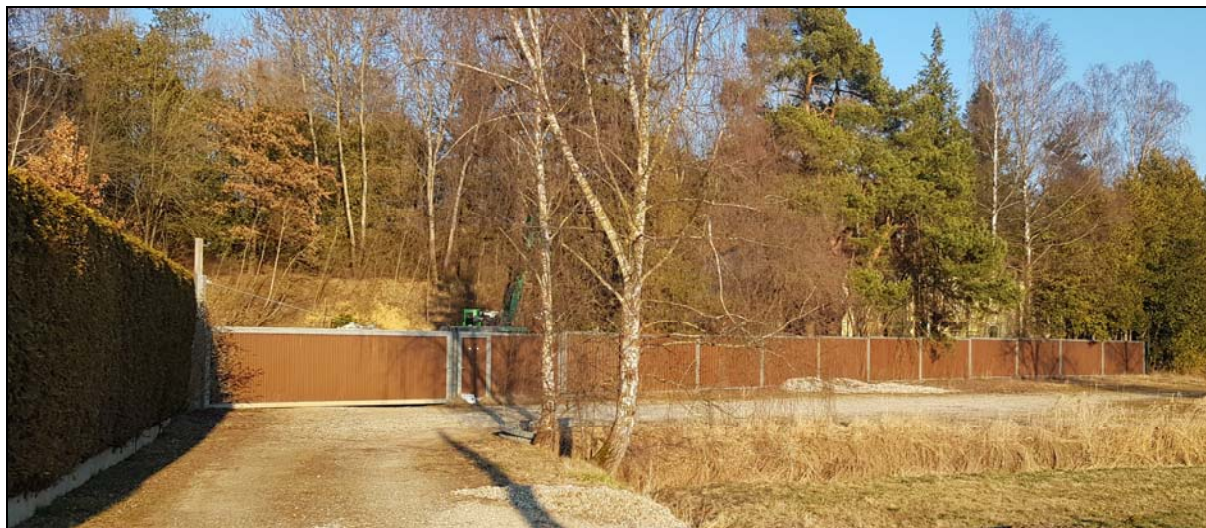
Bild 4: Koch Recycling, Lagerplatz; Westansicht
