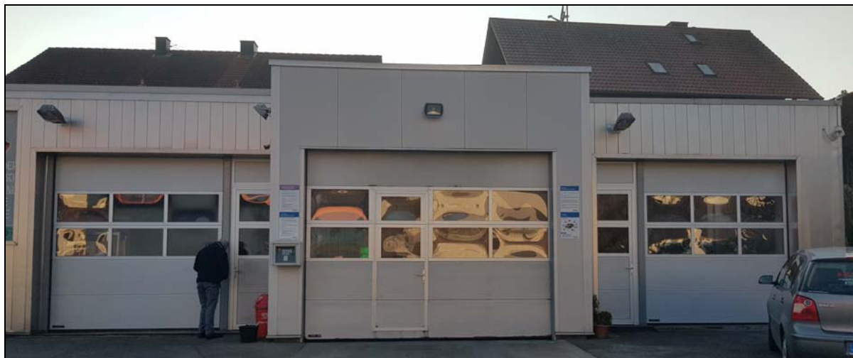
Bild 3: Gebäude mit Waschhalle (Tor rechts) der Tankstelle Heigl; Ostansicht
