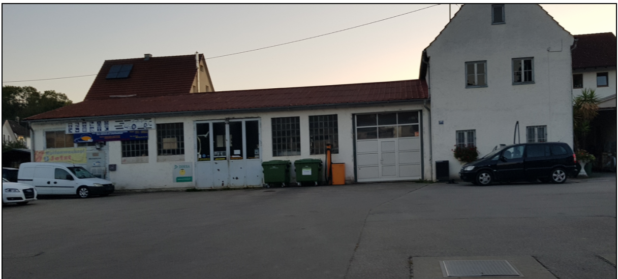
Bild 2: Werkstattgebäude der Tankstelle Heigl; Ostansicht
