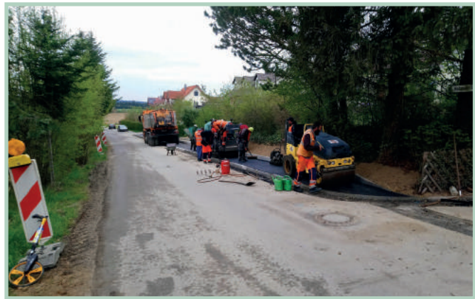
Asphaltierung des Gehwegs an der Holzmairstraße in Reichertshausen
