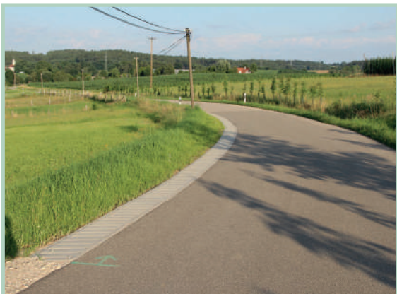
Kurvenbefestigung in Günzenhausen
