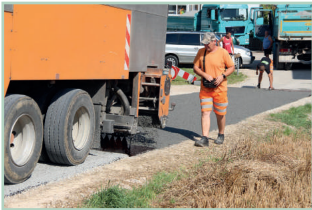
Aufbringen der Tränkdecke am Radeweg in Reichertshausen
