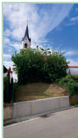
Abriss Kühlkeller und Errichten einer Stützwand (links)
