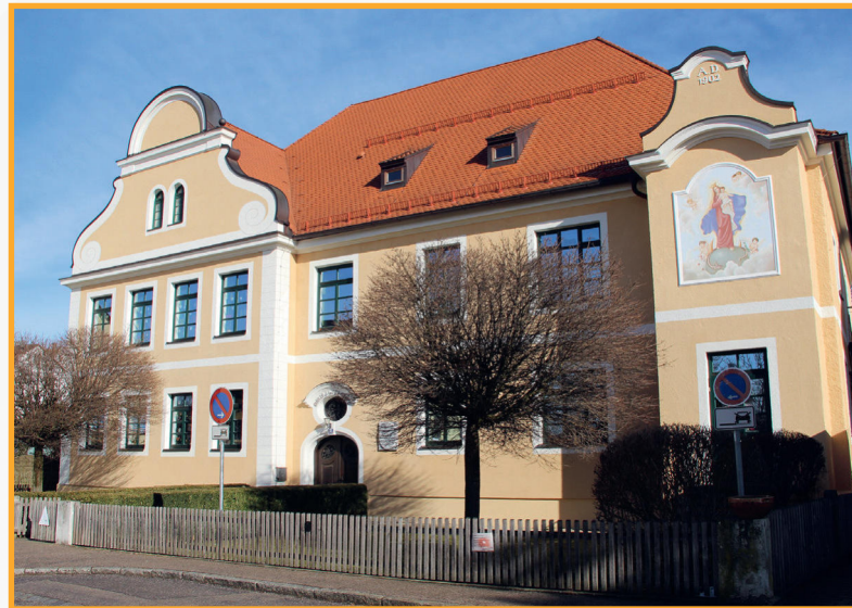
2012 wurde der Dachstuhl und die Außenfassade saniert. Von außen macht das Gebäude einen soliden Eindruck.
