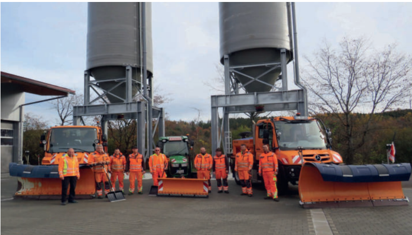
Die neuen Salz-Silo im Bauhof am Eschenring : Foto: Markt Au
