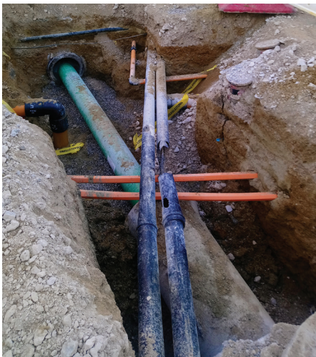
Sparten während der Bauarbeiten
