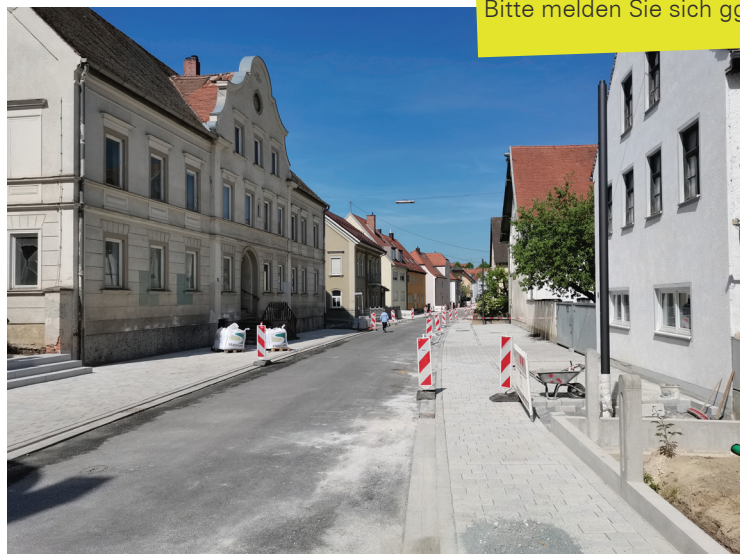
Neu gestaltete Untere Hauptstraße im Bauabschnitt 1.1
